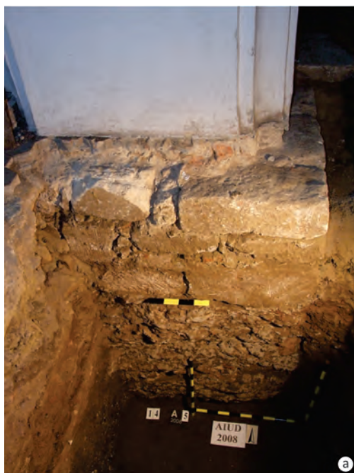
Figura 26. Secțiunea S.05, perspectivă către profilul de nord, cu fundația stâlpului dintre colaterală și nava centrală (a), către profilul de vest (b) și către profilul de sud, cu fundații suprapuse de amenajări cu beton (c) / Trench S.05, view towards the north, with the foundation of the pier between the side aisle and the nave (a), towards the west (b), and towards the south, with overlapping foundations and concreting interventions (c).
