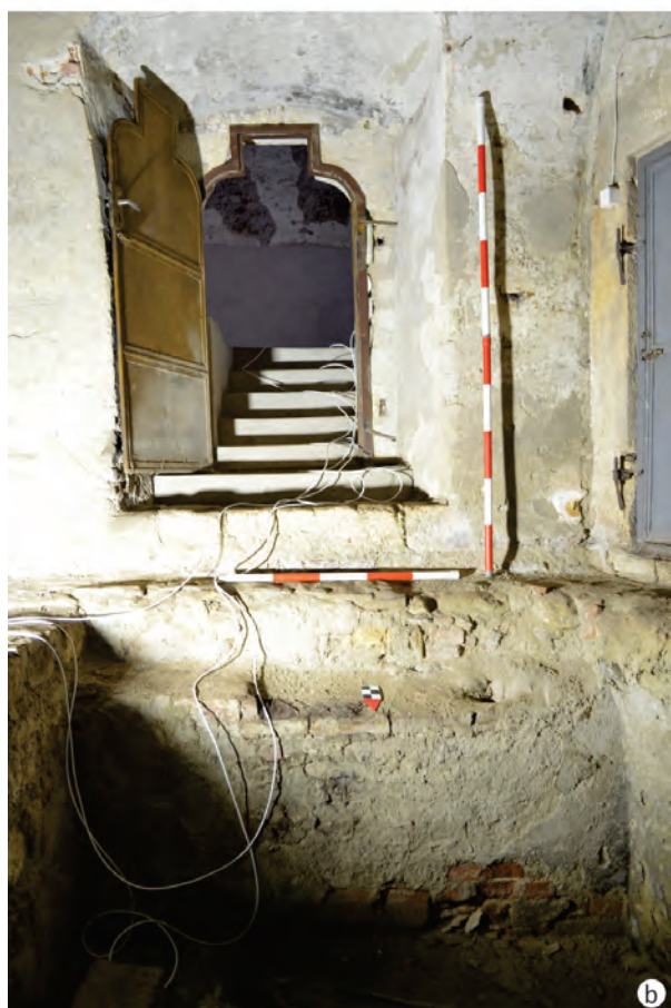
Figura 38. a) Secțiunea S.01, în exteriorul bisericii – actuala latură de est a colateralei de sud, constând în fapt dintr-un contrafort al corului, la care s-a adosat zidăria colateralei propriu-zise; b) Secțiunea S.02, în exteriorul bisericii – țeserea dintre fundația corului și fundația laturii de est a sacristiei / a) Trench S.01, outside the church – the current east side of the southern aisle, consisting in fact of a choir buttress, to which the masonry of the side aisle was attached; b) Trench S.02, outside the church – the interlinked masonry of the foundations of the sanctuary and of the east side of the sacristy.
