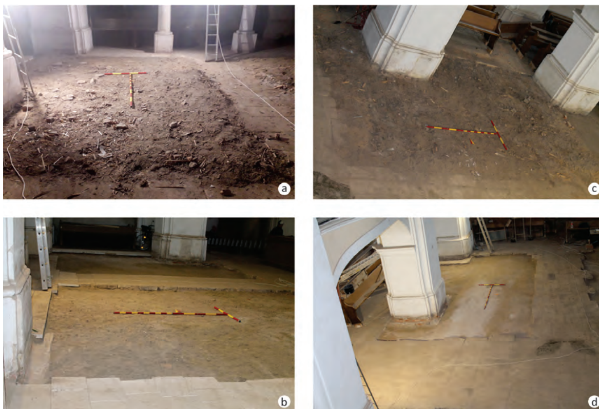
Figura 10. Zona de sud-vest a navei înainte (a) și după (b) coborârea de nivel, respectiv zona de nord-est a navei înainte (c) și după (d) aceeași coborâre de nivel / The south-western area of the nave before (a) and after (b) the vertical level adjustment, respectively the north-eastern area of the nave before (c) and after (d) the same vertical level adjustment.
