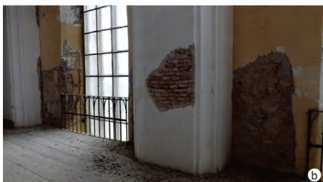
Figura 41. a) Stâlpi „baroci” în jumătatea de nord a bisericii, după îndepărtarea tencuielii, cu structura de piatră profilată și cărămidă expusă; b) pilaștri „baroci” la nivelul galeriei, cu structura de cărămidă expusă și relevându-și adosarea la tencuiala preexistentă a colateralei; c) detaliu cu adosarea unei pilaștru „baroc” la tencuiala preexistentă / a) “Baroque” piers in the northern half of the church, after the removal of the plaster, exposing their structure of carved stone and brick; b) “baroque” pilasters at the level of the gallery, with their brick structure exposed, revealing their abutment to the pre-existing plaster of the side aisle; c) detail with the abutment of a “baroque” pilaster to the pre-existing plaster.
