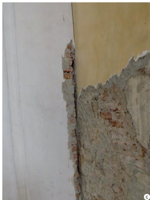
Figura 41. a) Stâlpi „baroci” în jumătatea de nord a bisericii, după îndepărtarea tencuielii, cu structura de piatră profilată și cărămidă expusă; b) pilaștri „baroci” la nivelul galeriei, cu structura de cărămidă expusă și relevându-și adosarea la tencuiala preexistentă a colateralei; c) detaliu cu adosarea unei pilaștru „baroc” la tencuiala preexistentă / a) “Baroque” piers in the northern half of the church, after the removal of the plaster, exposing their structure of carved stone and brick; b) “baroque” pilasters at the level of the gallery, with their brick structure exposed, revealing their abutment to the pre-existing plaster of the side aisle; c) detail with the abutment of a “baroque” pilaster to the pre-existing plaster.
